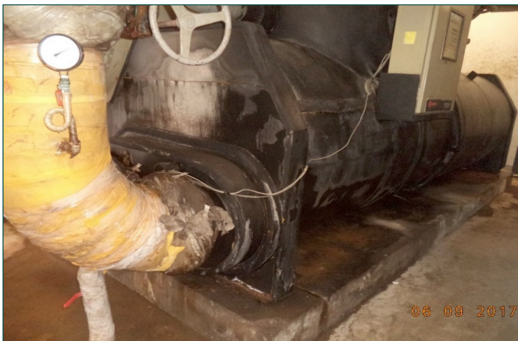
Động nước do cách nhiệt không đạt yêu cầu kỹ thuật.
